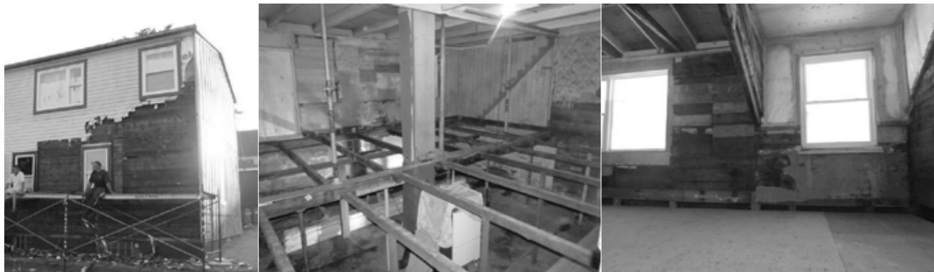
Restauration d'une maison traditionnelle Sabrina Trindade 2015
